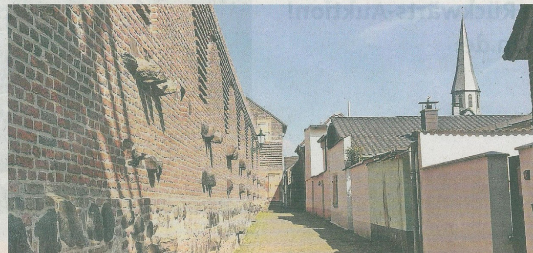
Der sanierte Abschnitt der Westmauer an der Mühle mit Blickrichtung St. Martinus. Die polnischen Besucher besichtigen das kleine Mühlenmuseum im ehemaligen Gefängnis und stiegen in der Mühle nach oben.
